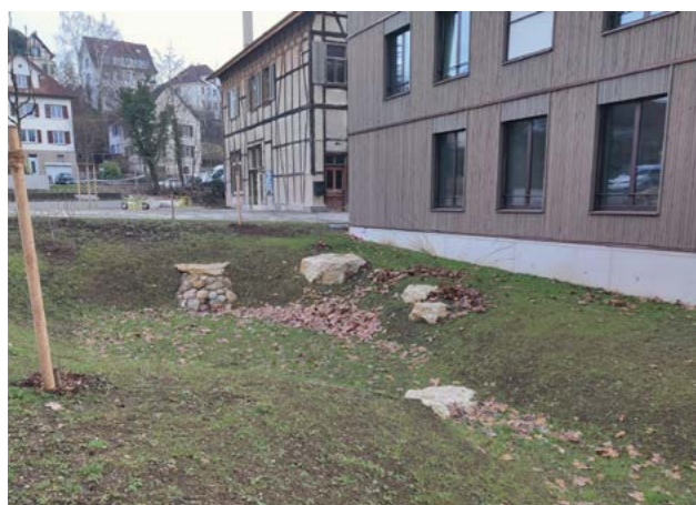
Regenwasser kann von bebauten Flächen via Versickerungsanlage versickert werden. Foto: H. Lacher
