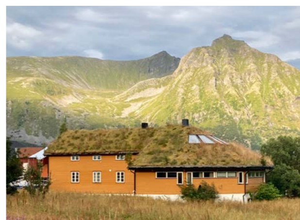
Gründächer bieten viele Vorteile wie verbessertes Raumklima durch Verdunstung von Regenwasser, Wasserrückhalt oder aber auch als Schutz der Dachabdichtung. Dachbegrünungen werden bei uns fast ausschliesslich auf Flachdächern realisiert. In anderen Ländern sind begrünte Schrägdächer jedoch keine Seltenheit. Foto: R. Arnheiter
