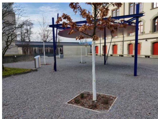
Versiegelte Flächen können wie bei der Kantonsschule Schaffhausen mit einfachen baulichen Massnahmen geöffnet werden: Der ehemalige Asphaltplatz wurde durch einen durchlässigen Kiesbelag ersetzt, so dass das Regenwasser zu den neu gepflanzten Bäumen fliessen kann. Dort steht das Wasser den Bäumen zur Verfügung und kann versickern. Foto: IKL
